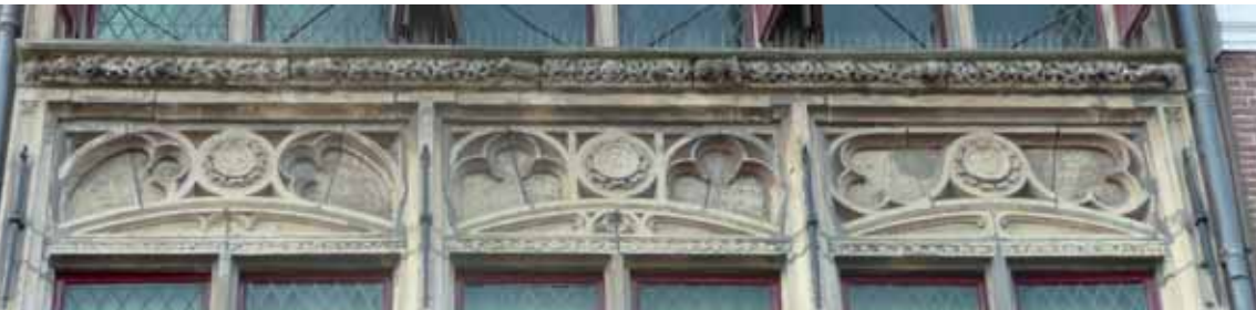
Waterlijst eerste verdieping met in de zich eronder bevindende medaillons de letters M, A en R. (Foto Theo van Mierlo)
